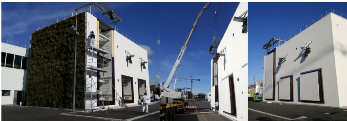
Figure 2.1 : Photo du bâtiment-test en cours de construction
