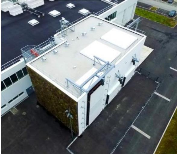
Dispositif unique en Europe, la Façade Test permet de **caractériser en environnement réel et à l'échelle 1** (grandeur nature) **le comportement thermique** (variation de la résistance thermique saisonnière et inertie), **hygrothermique** (risque de condensation et évolution de la teneur en eau des matériaux) **et les indicateurs de performances** (énergétique et confort thermique) sur un complexe d'enveloppe associé ou non à des systèmes actifs (CVC, ENR, etc.).
